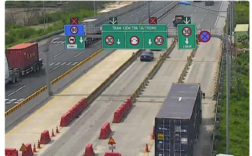
베트남 하노이-하이퐁 고속도로 건설사업(제7구간 및 제10구간)
