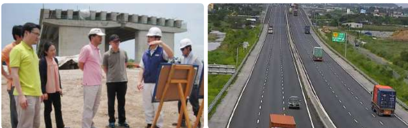
베트남 하노이-하이퐁 고속도로 건설사업(제7구간 및 제10구간)(전 후)
