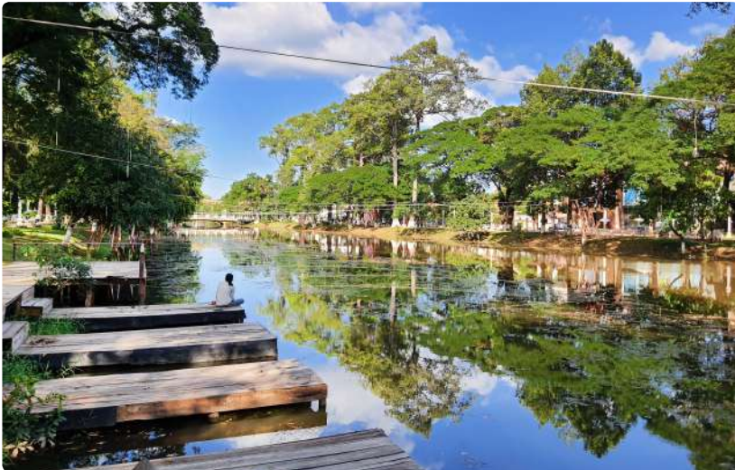
캄보디아 시엠립 하수처리 및 하천정비사업
