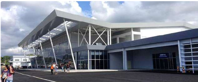
필리핀 팔라완주 푸에르토 프린세사 공항 개선사업(후)
