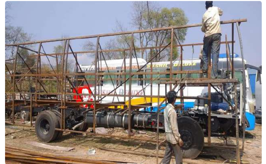
개도국 정보이용 환경개선(개도국 정보접근센터 구축·운영 사업) - 개조 작업
